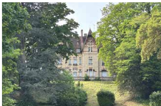
Au cœur du terrain occupé par l'ADSEA se dresse le Château des Boissières.
