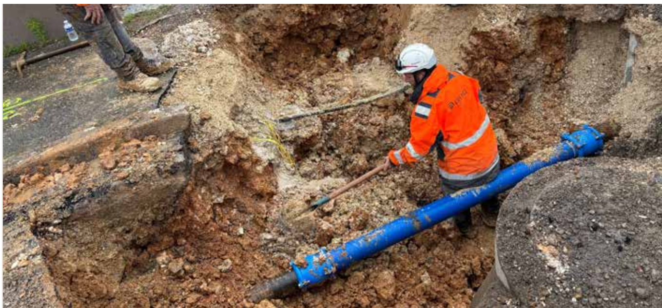
Dans le cadre de la route de Chavannes, renouvellement de la canalisation AEP (Aduction Eau Potable).
