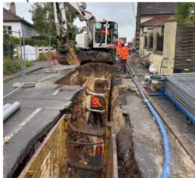
Pose canalisation EU (eaux usées) avec pompage pour la continuité du réseau.
