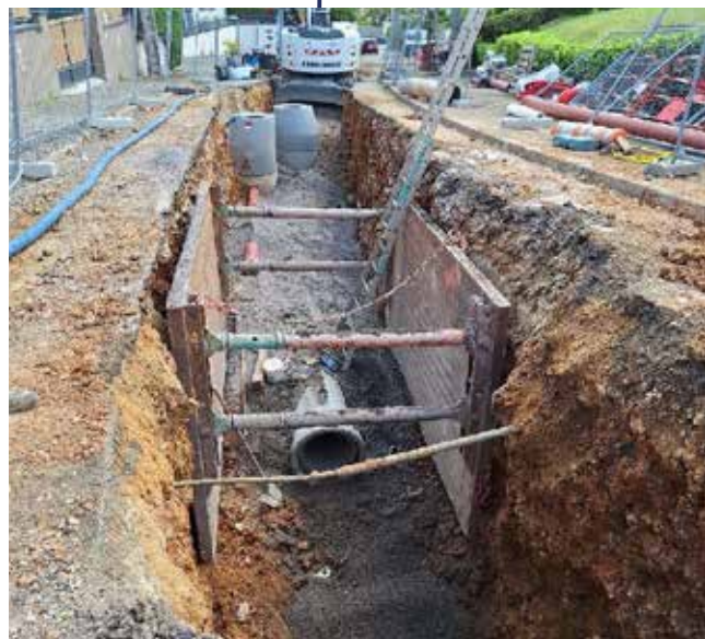
Nouvelle canalisation EP (eau potable).
