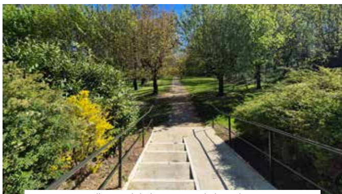
Travaux d'accessibilité au square de la Malonerie
