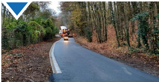
Afin d'améliorer la sécurité de la Route de la Butte Verte, la collectivité a obtenu du Département une reprise des bas côté avec mise en place d'une bordure de trottoir et une réfection partielle du tapis de voirie.
