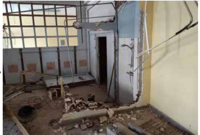
**Juillet 2021** - Début des travaux du bloc central (entre les deux ailes au rez-de-chaussée), qui va être complètement restructuré, avec la rénovation complète des sanitaires, la réorganisation des salles communes et la création d'un couloir avec accès à l'ascenseur.
