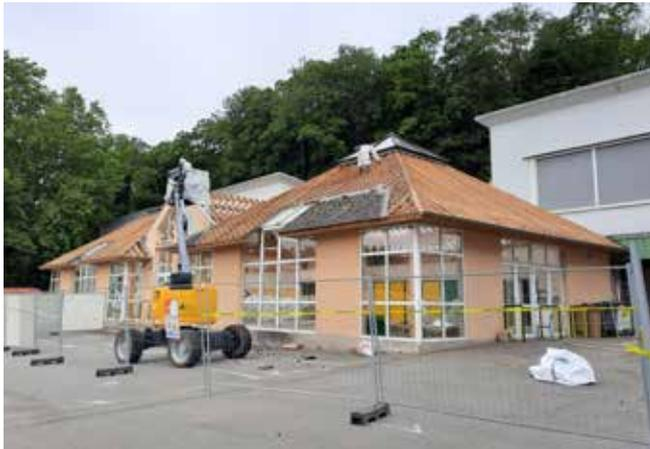
**Juillet 2021** - Lancement des travaux dès la fermeture de l'école pour les grandes vacances en juillet 2021, avec la réfection de la toiture du préau (désamiantage, pose d'une nouvelle couverture en zinc, isolation thermique et phonique) et le début des travaux du bloc central.
