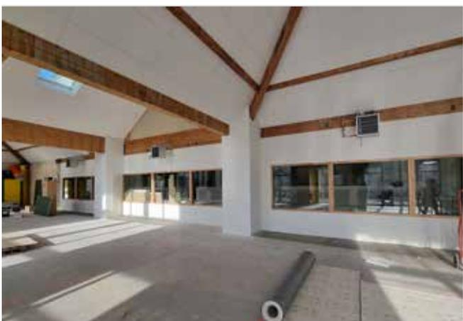
**Août 2022** - L'intérieur du préau, où l'on voit ici le nouveau plafond qui bénéficie d'une rénovation thermique et phonique ainsi que la nouvelle cloison intérieure, en transparence sur le nouveau couloir.
