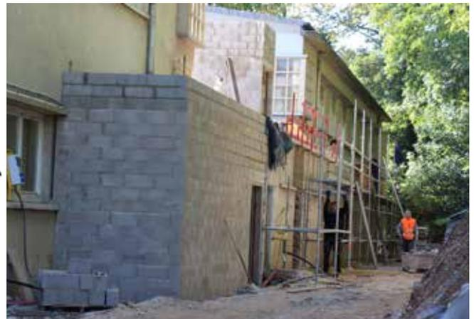
**Octobre 2021** - Élévation de la coursive reliant les deux ailes de l'étage, avec création d'un ascenseur, de toilettes accessibles PMR à l'étage, d'une nouvelle chaufferie, d'un local de rangement et d'un local poubelle accessible par l'extérieur.
