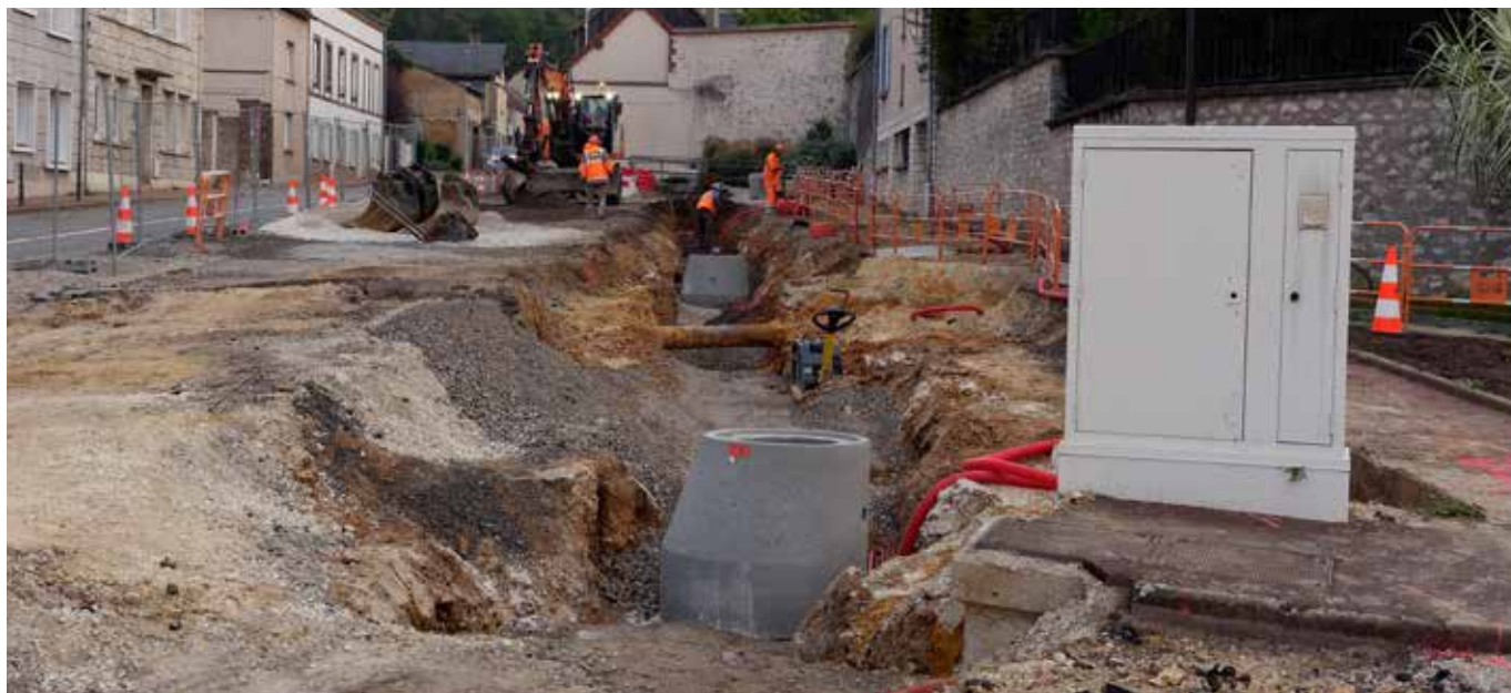
La société Colas sur l'ancien parking de La Poste en train de poser de nouvelles canalisations d'eaux usées.
