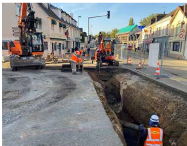
Préparation de la pose du nouveau réseau d'eau potable
