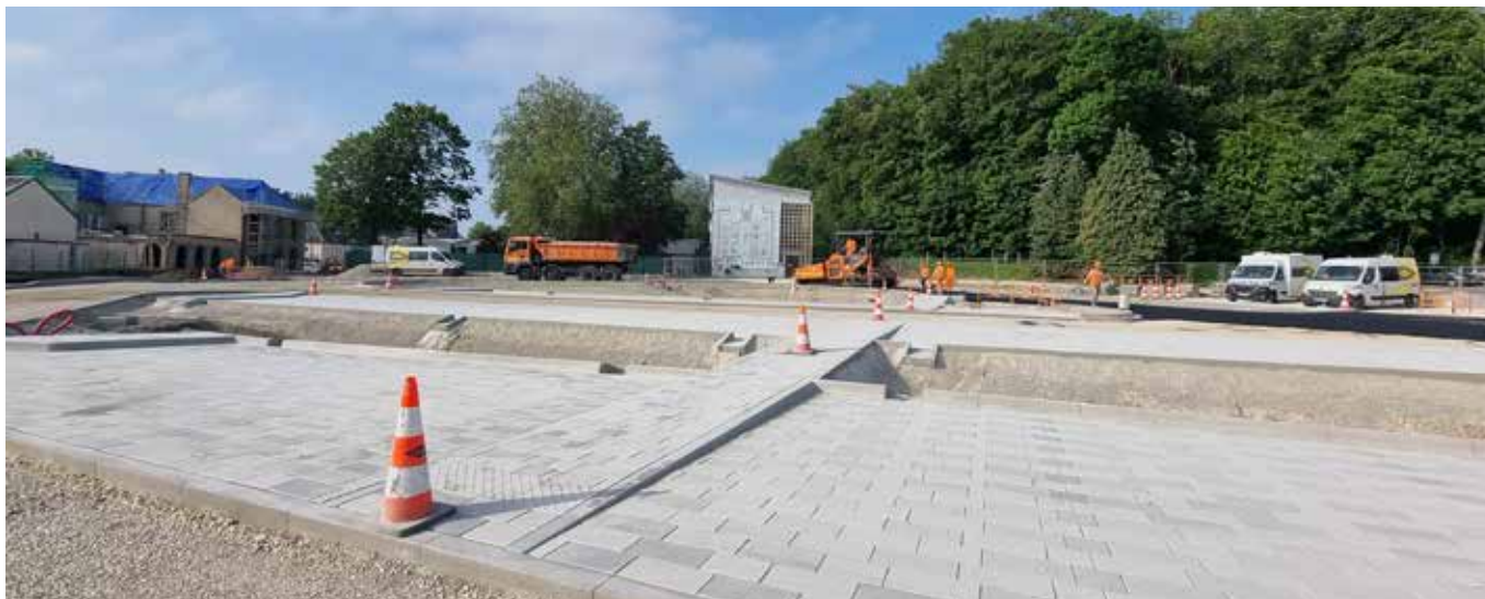
Création des nouvelles places de stationnement en pavés béton et cheminement piétons vers l'école.
