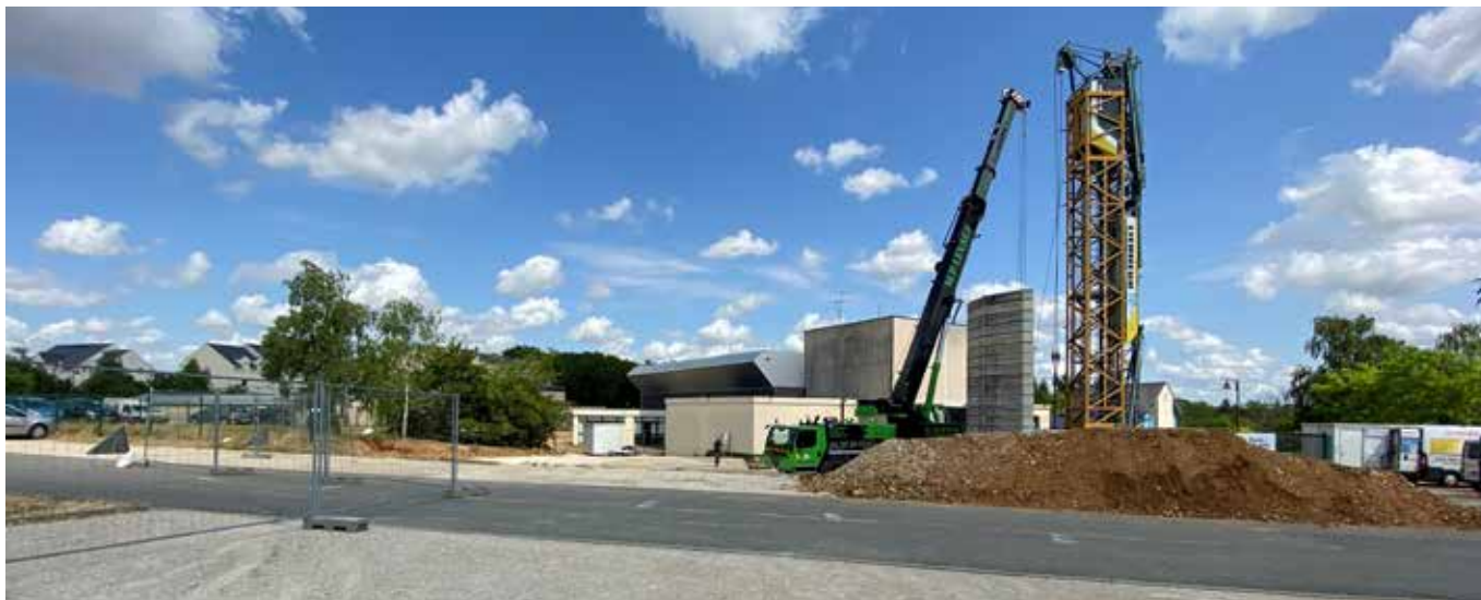
Après les terrassements commencés en avril, installation de la grue du chantier mi-juin, pour début de construction du bâtiment cet été.
