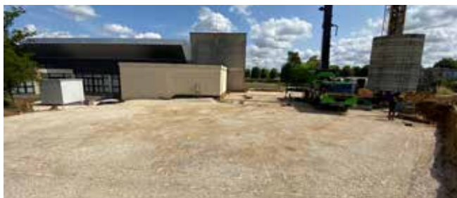
Le bâtiment jouxtera l'espace Soutine.
