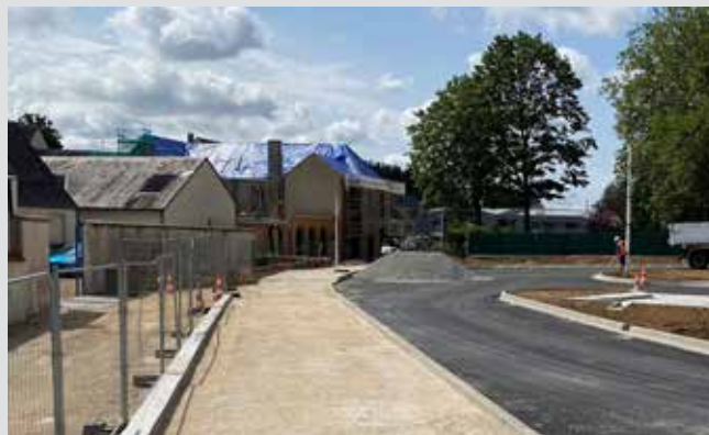
La promenade piétonne le long du Couasnon se dessine, depuis la rue Hoche Allart jusqu'à l'avenue de la Paix.
