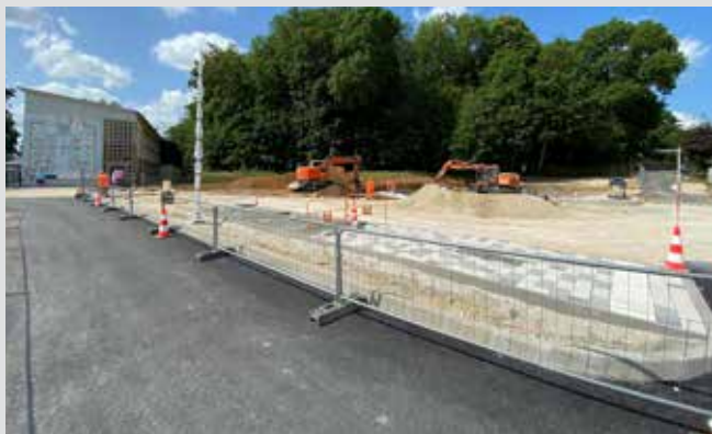
En cours de travaux, la deuxième partie du parking du Clos Bénin. Au total, 90 places seront réalisées sur l'ensemble de la phase 1.
