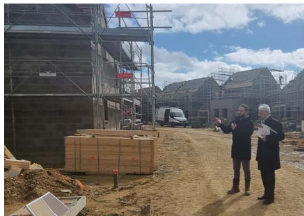
Les élus font un point régulier de l'avancement des différents chantiers, privés comme publics. Ici Joël Houvet, adjoint au maire (à droite), sur le chantier du lotissement du Clos Renault avec le représentant du promoteur Pierres et Territoires.
