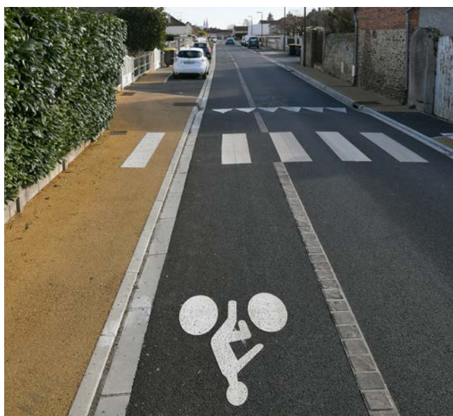
Une piste cyclable a été créée, et les trottoirs élargis.
