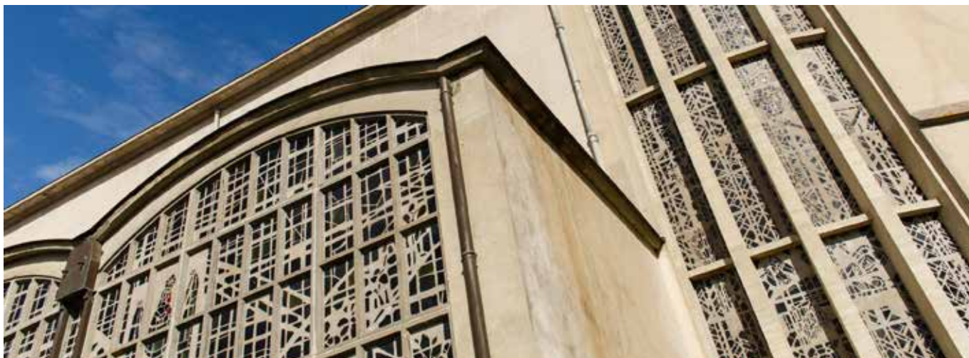
Le démarrage des travaux de l'église saint-Lazare est prévu en 2026.
