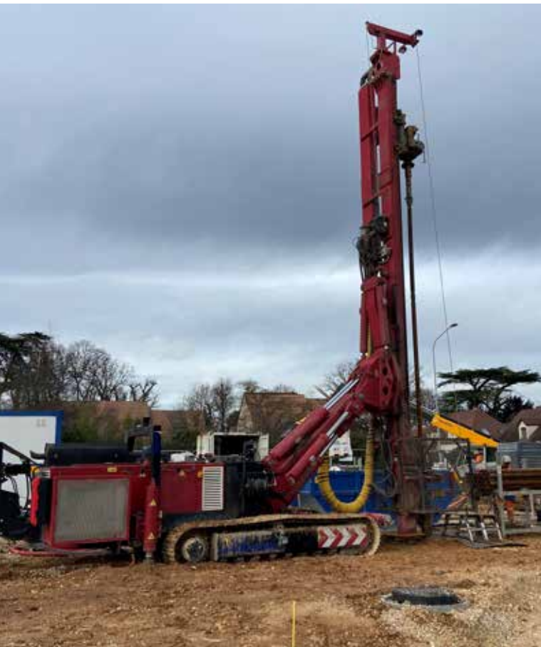
Forage des sondes de géothermie sur place en janvier.
