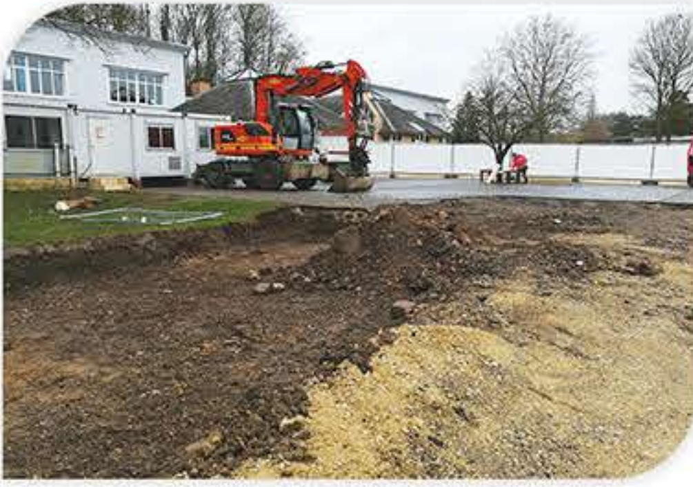
Mars 2018 : début des travaux pour préparer le terrain
