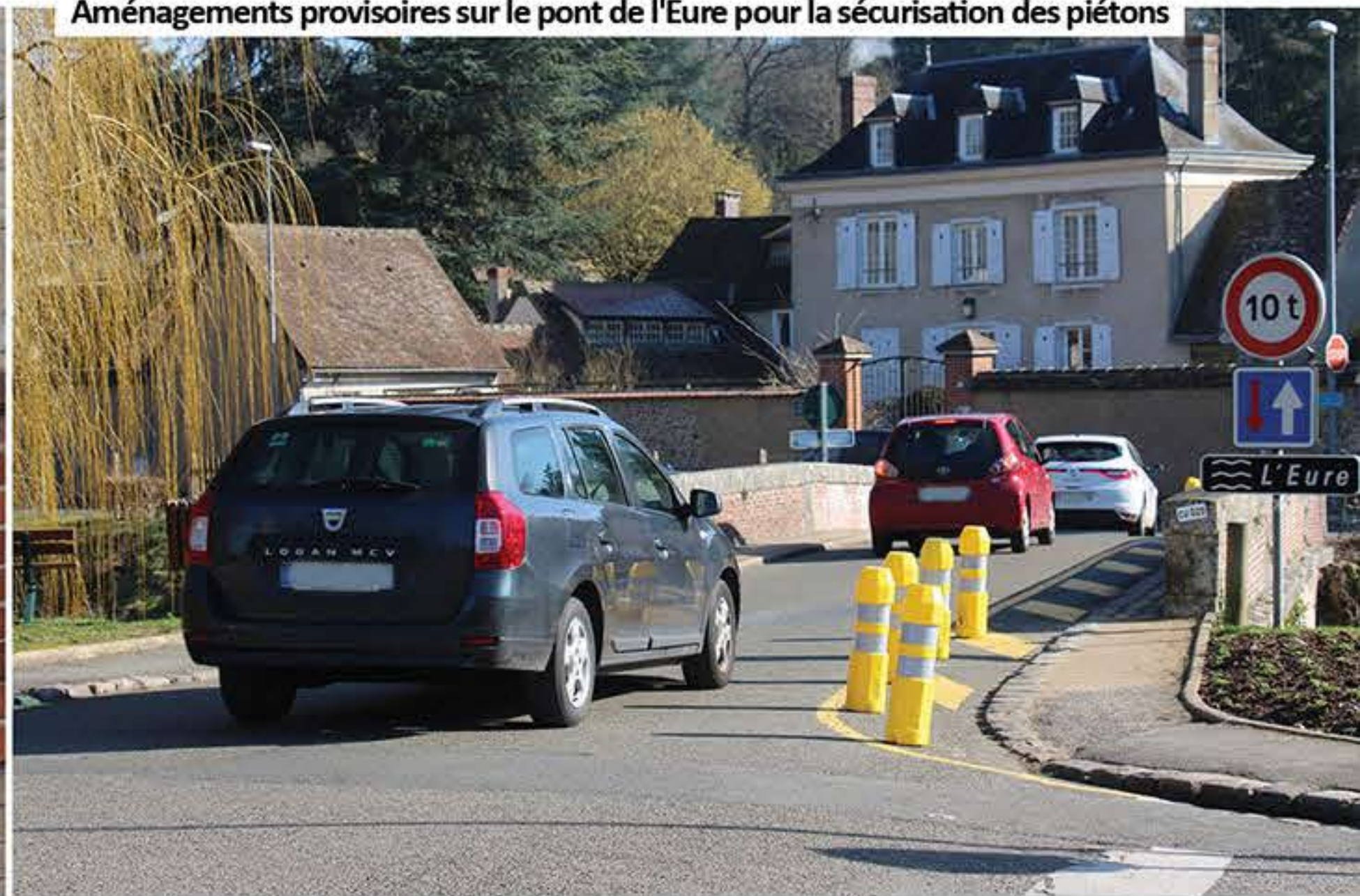
Aménagements provisoires sur le pont de l'Eure pour la sécurisation des piétons
