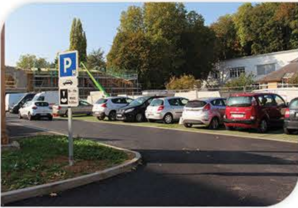
Septembre 2018 : le parking et la clôture de l'école sont achevés
