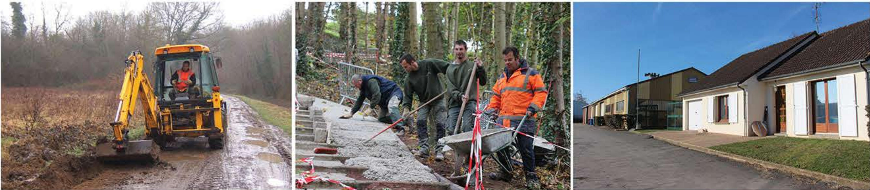
Entretien des chemins communaux, petits travaux de maçonnerie ou entretien des locaux - ici ceux du service technique - font partie des tâches des agents.
