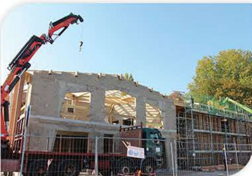
Octobre 2018 : les murs extérieurs sont terminés, le toit est posé
