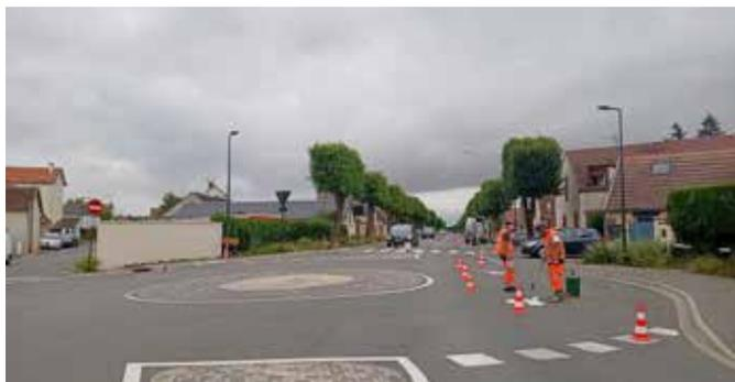
Dans le but de réduire la vitesse des véhicules en entrée de ville, des aménagements ont été réalisés sur des giratoires avec le renforcement et l'ajout de marquage au sol, la pose de pavés colorés et l'installation de plots réfléchissants (« yeux de chat »), et pour l'un des giratoires le rehaussement du ressaut et du dôme central.
