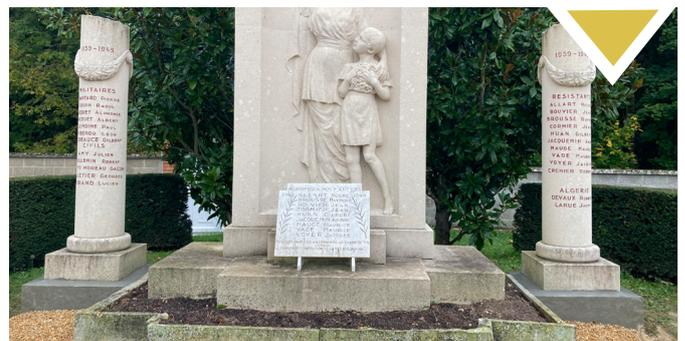
Le monument aux morts (cimetière) a été restauré avec la consolidation et la reprise en sous-œuvre des socles sous les 2 colonnes latérales.
