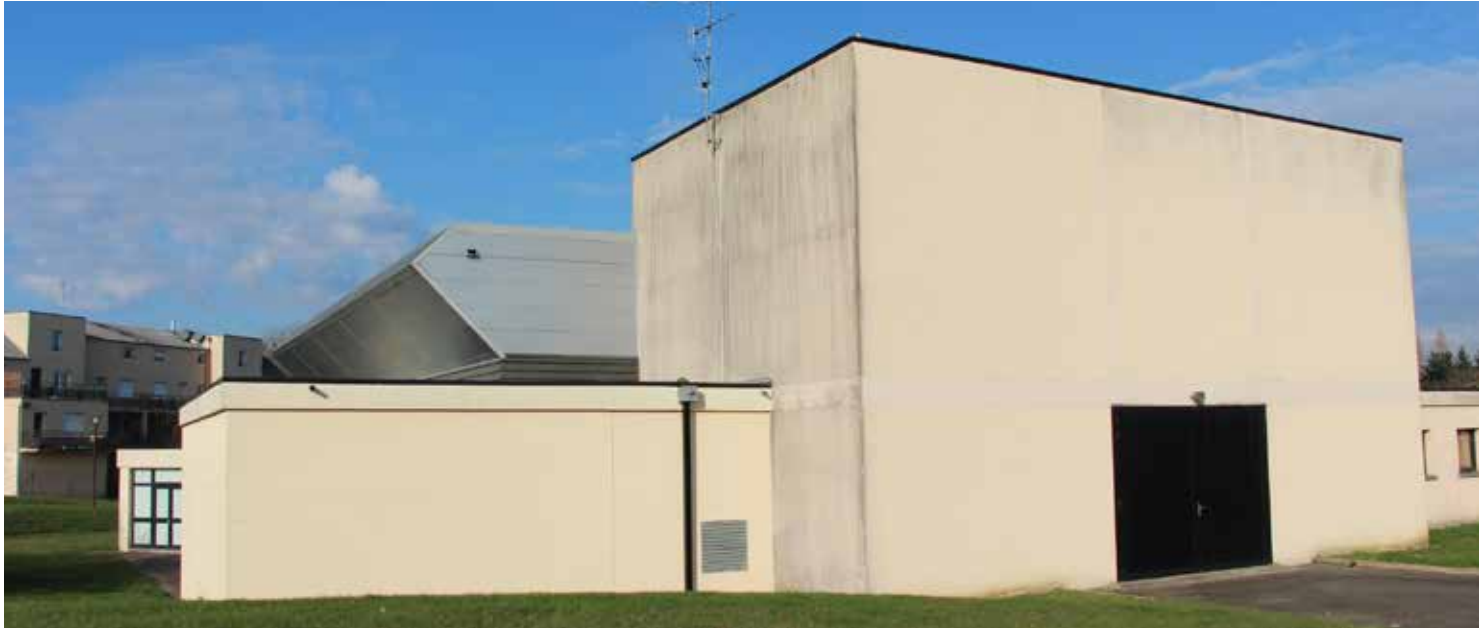
L'arrière de l'Espace Soutine, où sera construit le nouveau bâtiment de l'école de musique, avec accès direct à la scène.
