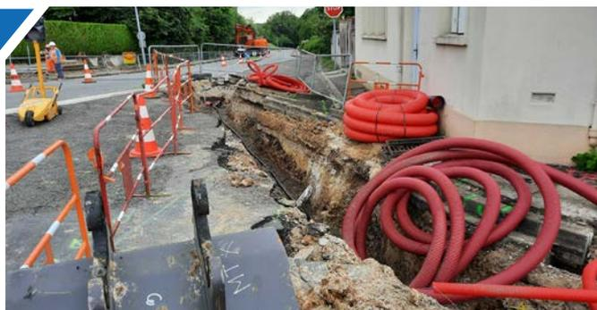
La reprise des réseaux électriques et de télécommunications aux extrémités de la rue de Bailleau et la réalisation de la tranchée unique pour ces réseaux secs marquent le début du chantier. Le nouveau giratoire a été progressivement créé avec la modification du réseau d'eaux pluviales puis l'installation des bordures pendant la période estivale.
