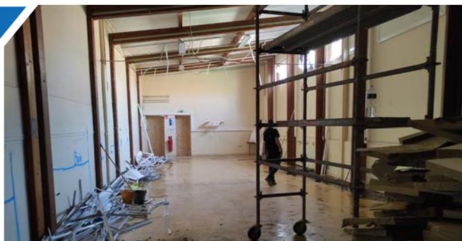
Les travaux de l'école Jules Vallain ont débuté dès la fin des classes, soit le 7 juillet dernier. Ainsi les opérations de désamiantage de la couverture du préau sont déjà terminées ce qui va permettre la mise en place d'une nouvelle toiture. En parallèle, l'entreprise de gros œuvre a commencé les opérations de démolition de la zone centrale, et des cloisons étanches ont été mises en place afin de permettre aux travaux de continuer à la rentrée sans gêner le fonctionnement de l'école.
