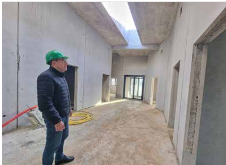
Daniel Desgrouas, adjoint au maire en charge du projet, au sein du hall desservant l'ensemble des salles.
