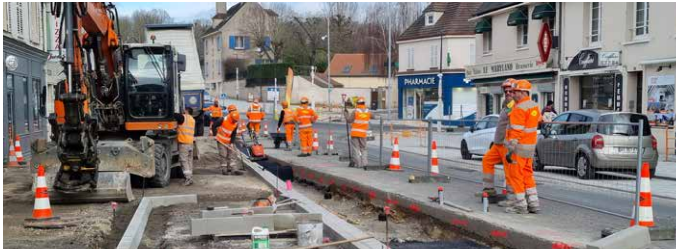
Travaux de la phase 2 des aménagements publics du cœur de village : pose des bordures et caniveaux côté pair de l'avenue de la Paix.
