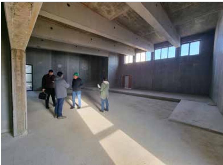
Le futur auditorium, doté d'une estrade et pouvant recevoir un public de 80 personnes en format assis.
