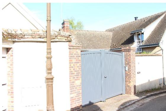
**Mur traditionnel pour le bâti ancien** : mur maçonné enduit avec piliers en brique surmontés d'un chapeau de mur « en dos d'âne ». Chainage en briques. Maison implantée à l'alignement par le pignon. Unité entre le mur de façade et le mur de clôture.
