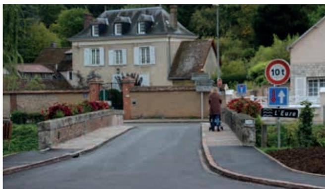
Un nouvel aménagement du pont de l'Eure a été réalisé avec l'élargissement des trottoirs et le rétrécissement de la chaussée pour réduire la vitesse des véhicules et améliorer la sécurité des piétons.
