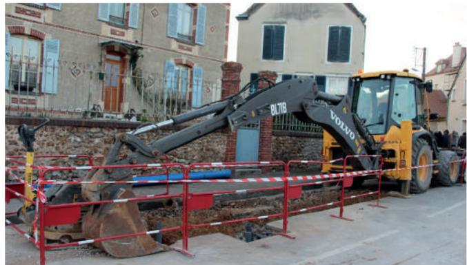
Les travaux des rues de la Chacatière et Hoche Allart ont débuté en mars, pour se poursuivre jusqu'à fin juin. Les réseaux humides, en mauvais état, ont commencé à être repris, avant que les réseaux secs ne soient enfouis et que le nouveau revêtement soit posé.
