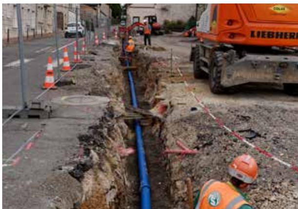
Tranchée sur l'ancien parking de la Poste pour procéder à l'installation de la conduite d'eau potable de diamètre 125 mm qui passe sous toute la longueur du carrefour (tuyau bleu).
