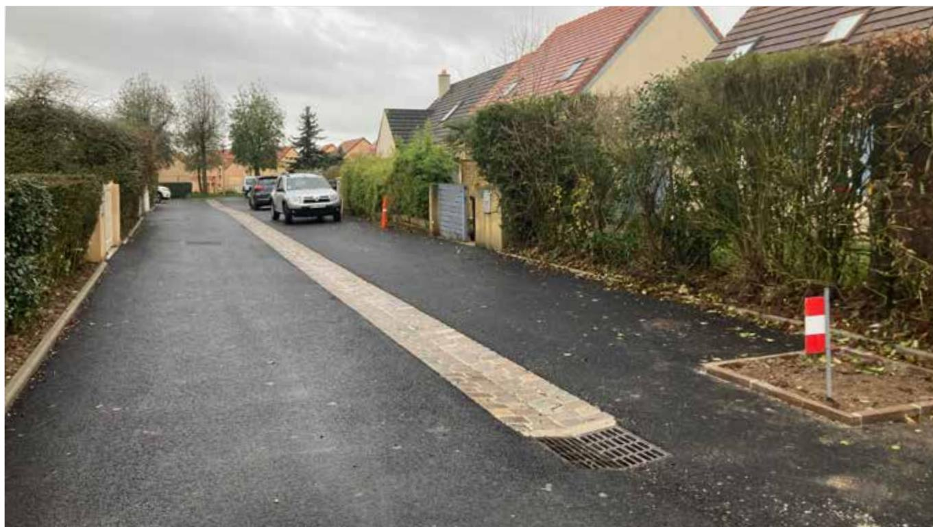
Suite à la demande des riverains, l'allée des Laris a été réaménagée pour réduire les nuisances liées aux racines des arbres car celles-ci détérioraient la voirie en surface et les réseaux d'assainissement en souterrain.
