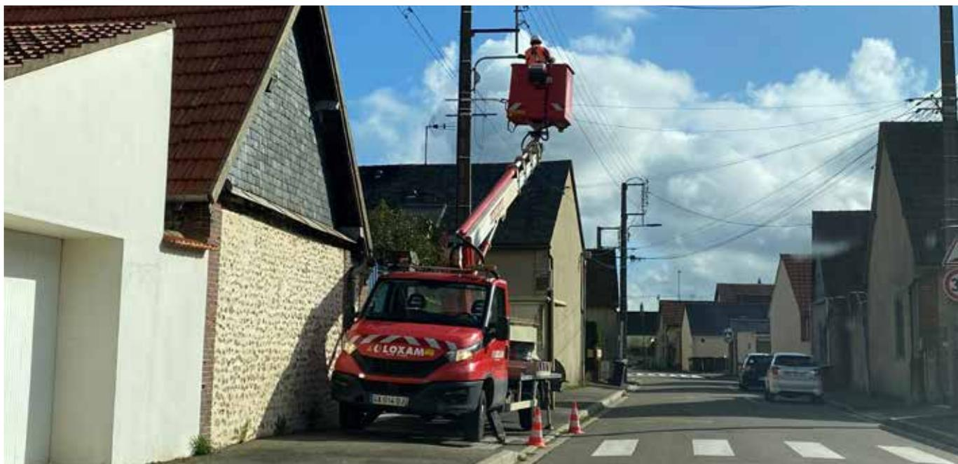
Ici luminaires route de Chavannes, remplacement des ampoules à mercure par des ampoules en led.
