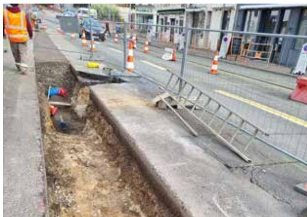
Tranchée sur l'avenue de la Paix pour l'installation d'une nouvelle canalisation d'eau potable de diamètre 100 mm qui dessert les différents commerces de l'avenue.
