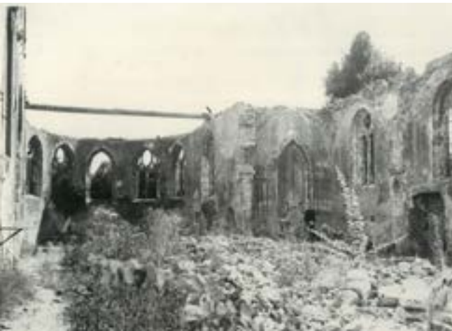
De nombreux bâtiments de Lèves ont été démolis lors de la bataille, qui fit rage durant toute l'après-midi jusqu'à 22h30. Symbole de ces destructions, l'église complètement éventrée, qui sera reconstruite dans les années 50.
