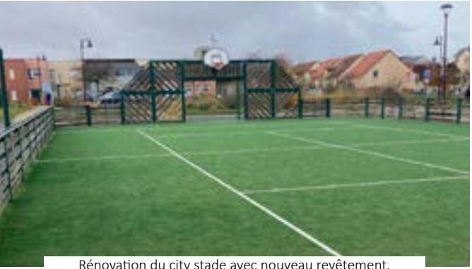
Rénovation du city stade avec nouveau revêtement.
