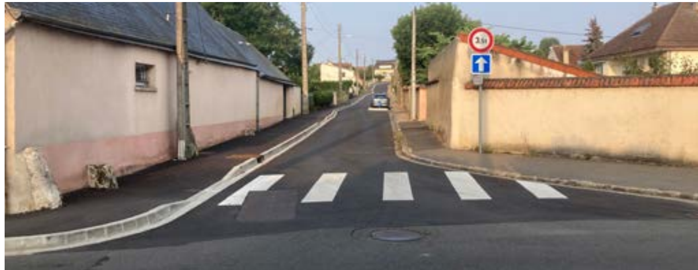
Vue de la rue du Petit Orme depuis l'avenue de la Paix après travaux.
